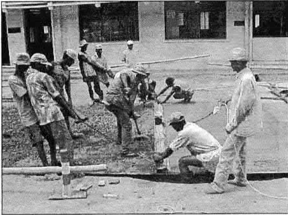
Construction d'une chaussée en béton armé à Tamatave, fin octobre 2001. Ou une autre manière d'utiliser le ciment.
