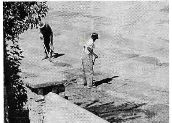
Enlever la boue du bitume: Une tâche quotidienne des employés du Firaisana II en temps de pluie!
