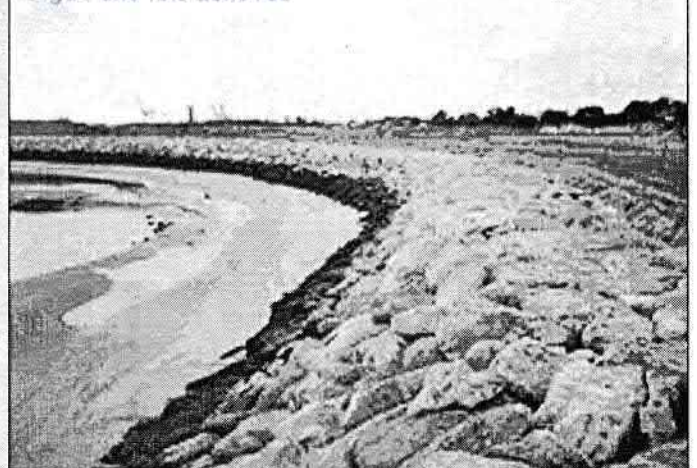
Digue une fois achevée
