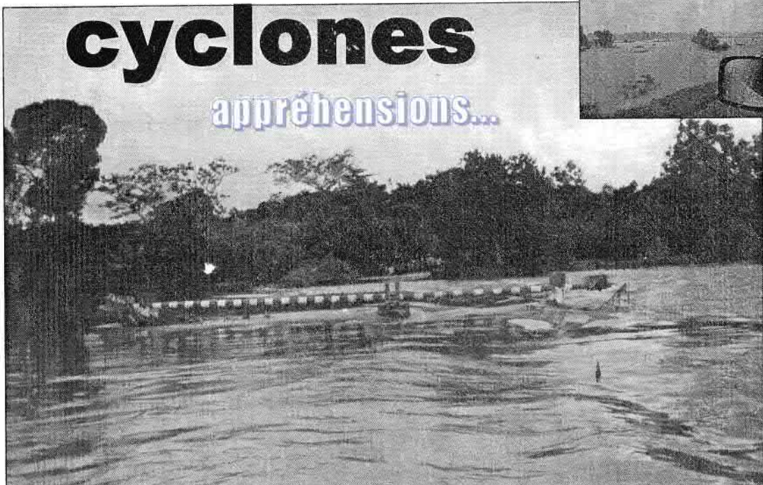
Les dégâts engendrés par le cyclone sur les routes sont souvent impressionnants, ici, seule une barrière de pluie immergée rappelle l'existence d'une route quelques heures plus tôt.
