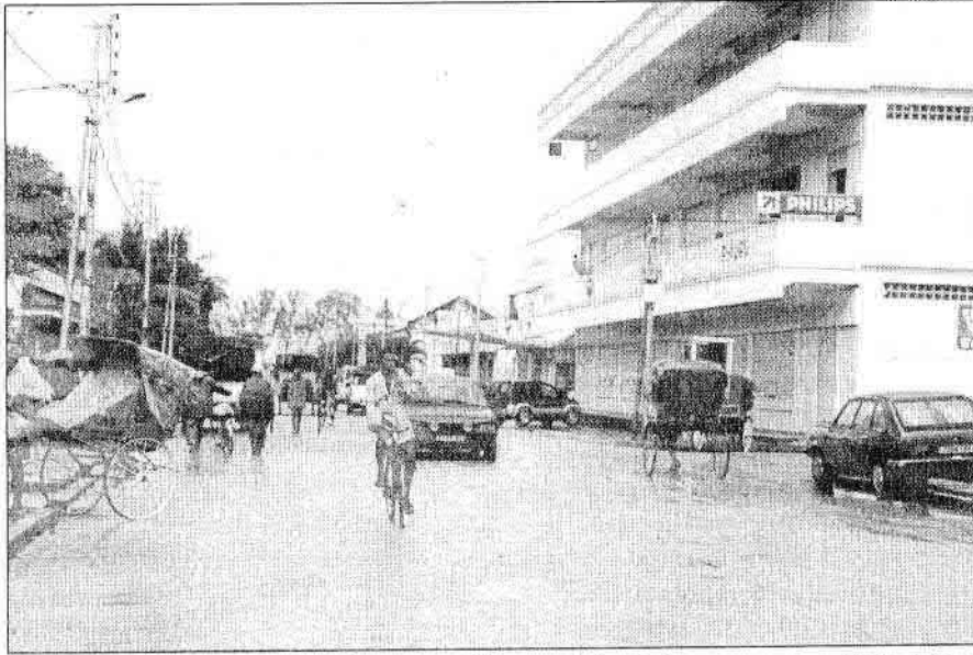
A Toamasina, la chaussée - béton passe l'épreuve de la pluie
