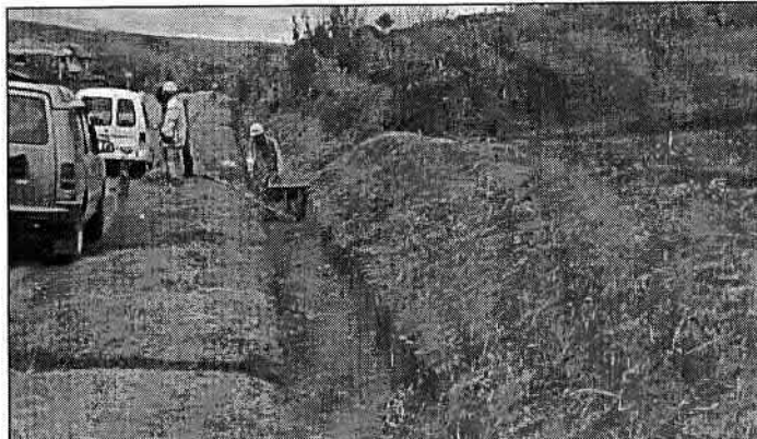
Un cantonnier à l'oeuvre (derrière la brouette) pour une mise en gabarit de fossé en terre. On remarquera également le travail d'assainissement correctement effectué : ouverture de saignée et de fossé.
