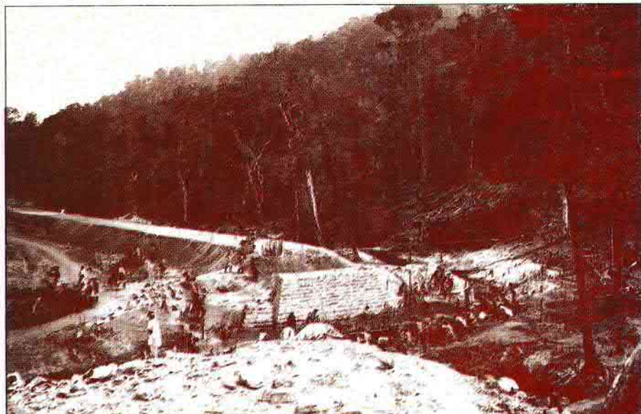
Les travailleurs aux chantiers des routes de Tamatave et de Majunga.
