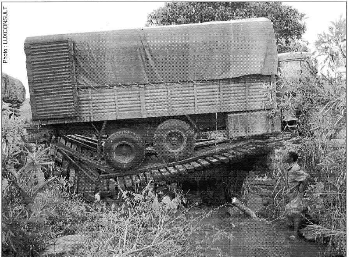
RN 27 : la charge du camion a eu raison de l'ouvrage déjà en piteux état. Quid des charges à l'essieu à Madagascar ?
