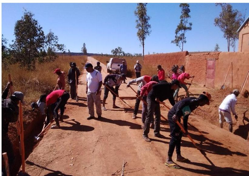
Pour la formation en extraction de pierre et pose pavé, ces mêmes cantonniers l'ont assisté en date du 12 au 17 septembre 2022. L'objectif de la formation est que les cantonniers puissent entretenir les routes en pavé à réaliser dans le cadre du projet et encore plus à étendre les routes en pavé par eux-mêmes
