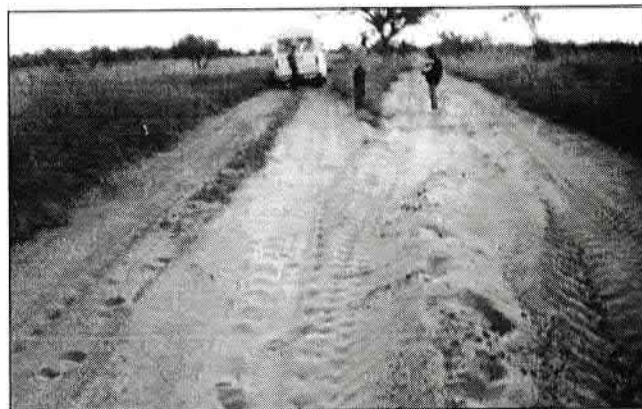
PK 93+600 : création d'une déviation.
