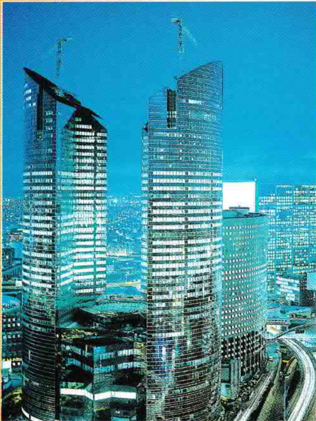
CONSTRUCTION DE DEUX TOURS AU SEIN DE LA DEFENSE, REGION PARISIENNE.
