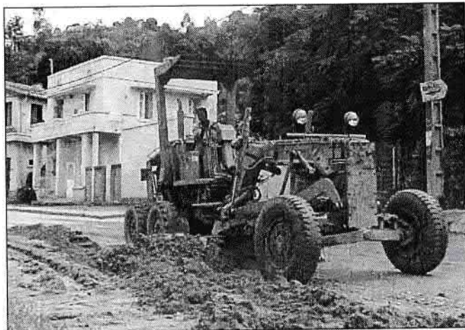
Cette niveleuse en action, contrairement à ce que l'on pourrait penser, ne fait pas de reprofilage mais enlève les sédiments accumulés par la pluie sur le bitume de la Route Circulaire !
