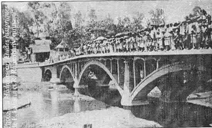
7 décembre 1930 : Inauguration du pont en arc de Tanjombato qui enjambe l'Ikopa près d'Antananarivo au PK 5 de la RN7. L'ouvrage est à deux voies charretières. Il comprend trois arches et une voûte de décharge qui permet le passage d'un canal d'irrigation. Il a une longueur totale de 96,60m et a coûté 800 000 Francs.
